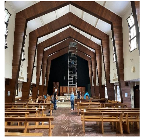
↑旧照明撤去工事の様子 ←聖堂正面に掲げられたイエス像
