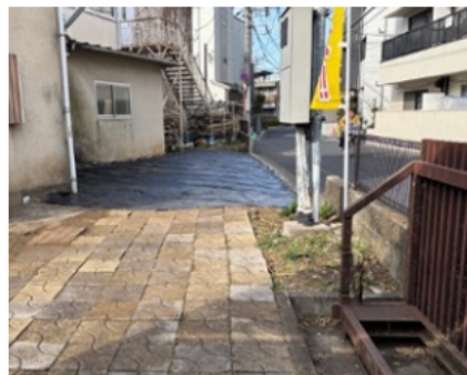
スカウトホーム裏の整備 2025.2
